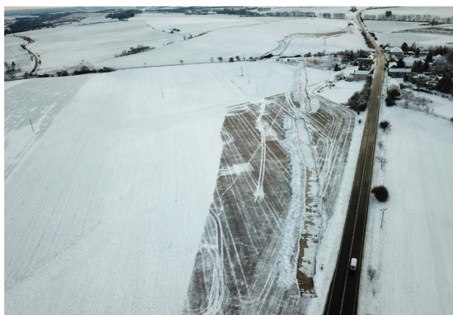
Skrývka v místě stavby dálnice D7, v úseku Slaný-západ – Kutrovice
